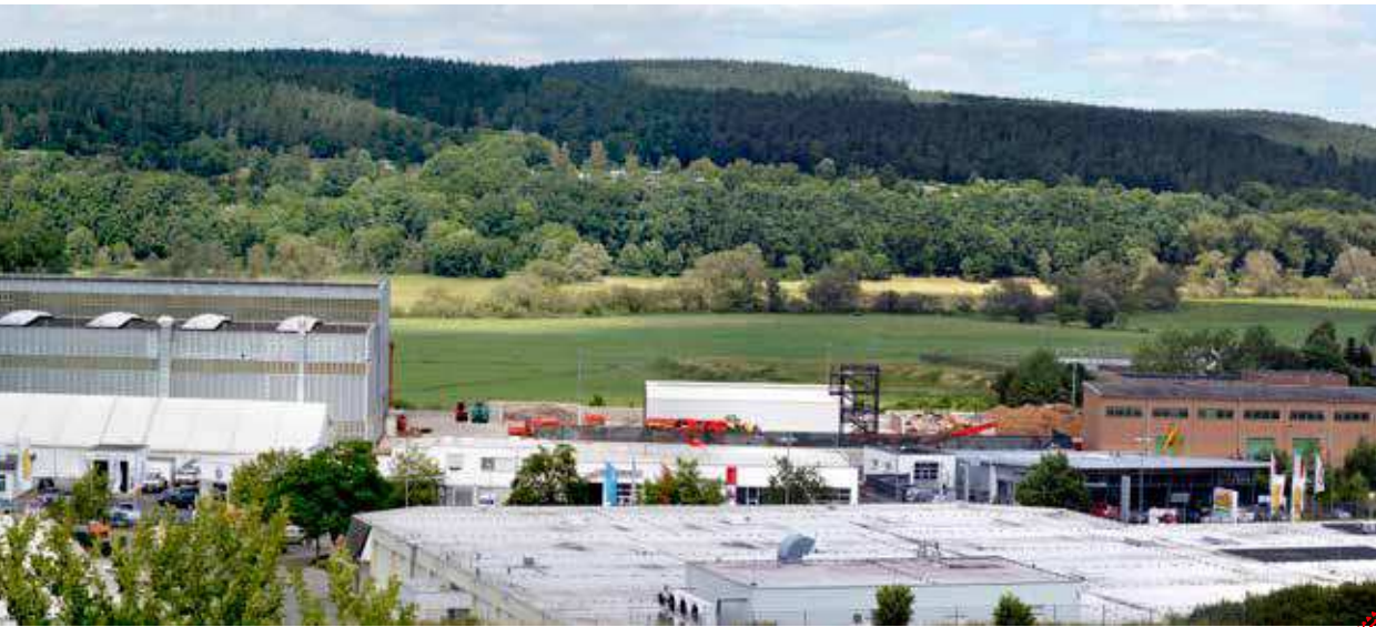
© Hammel General view of HAMMEL Recyclingtechnik GmbH in Bad Salzungen, Thuringia Gesamtansicht HAMMEL Recyclingtechnik GmbH im thüringischen Bad Salzungen
