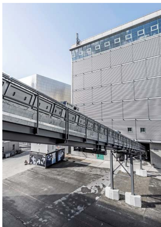
◀ Hagenholz waste incineration power plant Kehrichtheizkraftwerk Hagenholz
